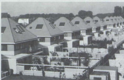
Sistemas solares térmicos instalados en una nueva urbanización en Woodhuis, Holanda.
