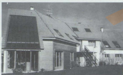
Vivienda con instalación de agua caliente y calefacción solar en Francia.
